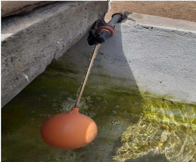
*Nota:* Sistema que permite y detiene el flujo del agua para el llenado del tanque.
