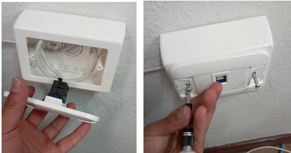
Figura 57 Instalación del punto de red para la mesa de trabajo.
