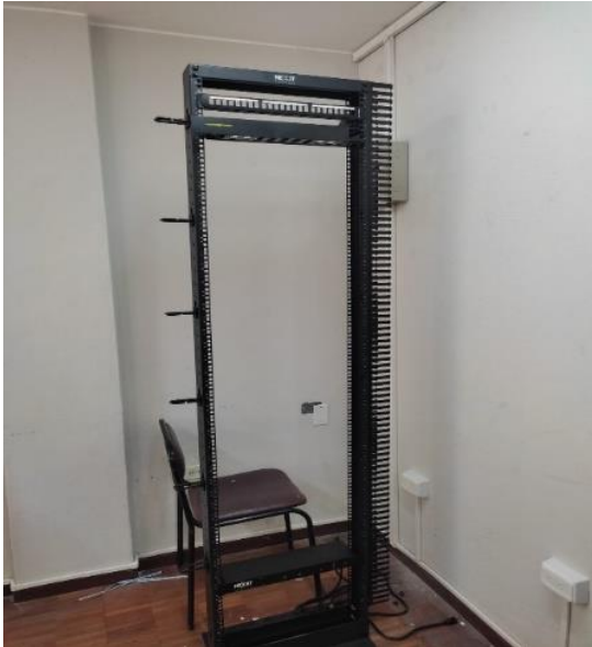
Figura 28. Instalación del rack.
