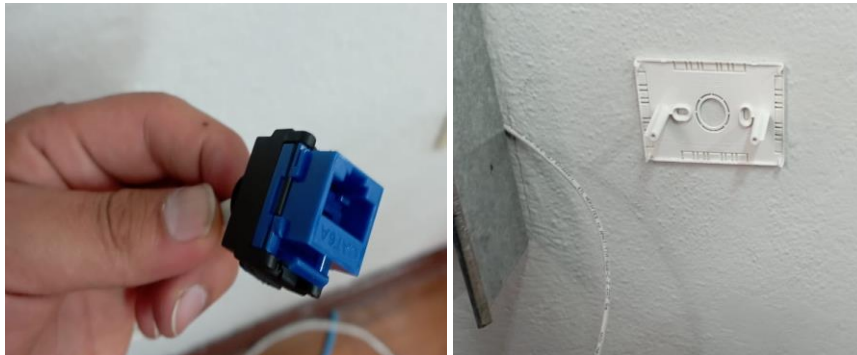
Figura 56. Instalación del punto de red para la mesa de trabajo.
