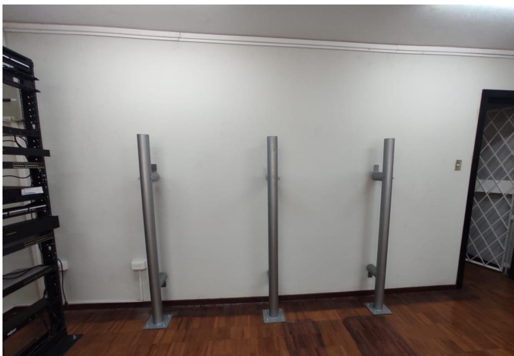
Anexo 8. Postes ya colocados para el módulo de prácticas del ITI
