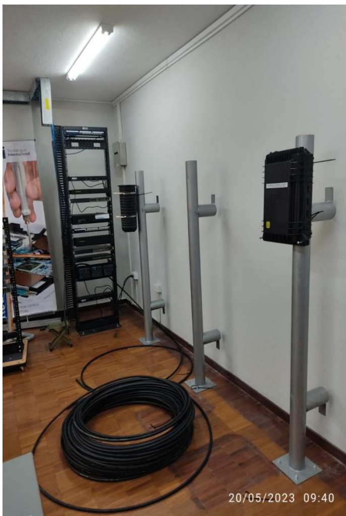
Anexo 17. Paso de fibra a través de los mini postes
