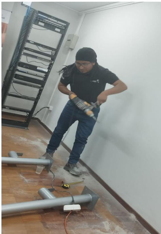
Anexo 5. Perforación del piso para aseguramiento de los mini postes
