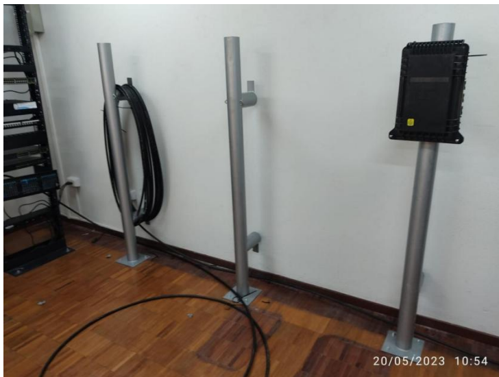
Anexo 16. Colocación de los terminales de fibra en el módulo de fibra óptica
