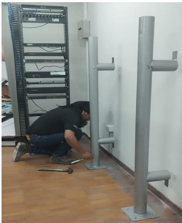
Anexo 6. Fijación con pernos expansores
