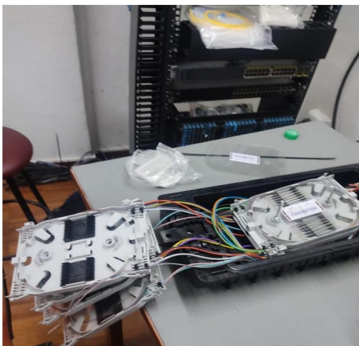
Anexo 24. Sangrado y preparación de fibra para la fusión
