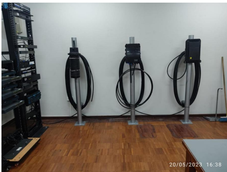
Anexo 19. Tendido y colocación de terminales de FO terminados
