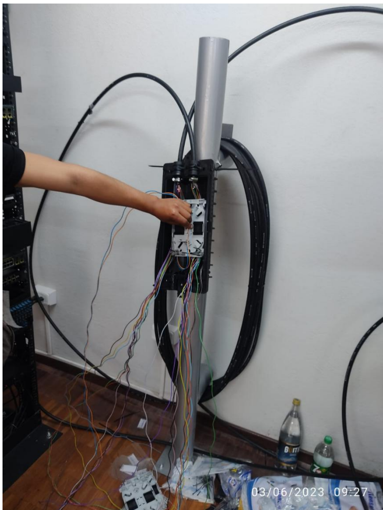
Anexo 22. Sangrado y preparación de fibra para la fusión
