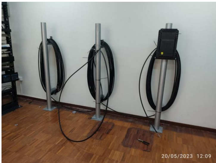
Anexo 18. Posicionamiento de 100 metros de fibra en el módulo didáctico
