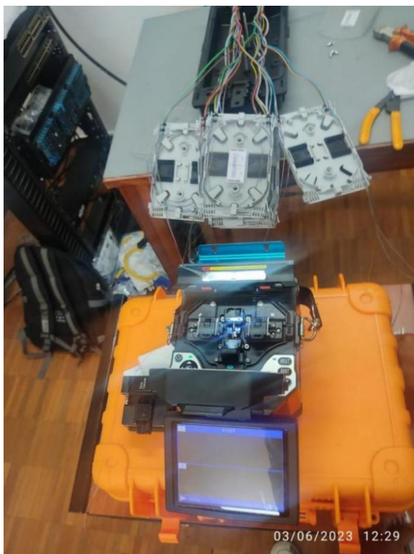
Anexo 26. Fusión de hilos asignados por cada terminal
