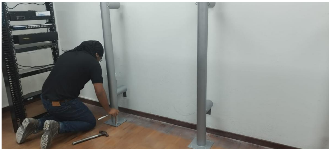
Anexo 7. Fijación con pernos expansores
