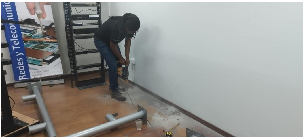
Anexo 4. Instalación de los mini postes
