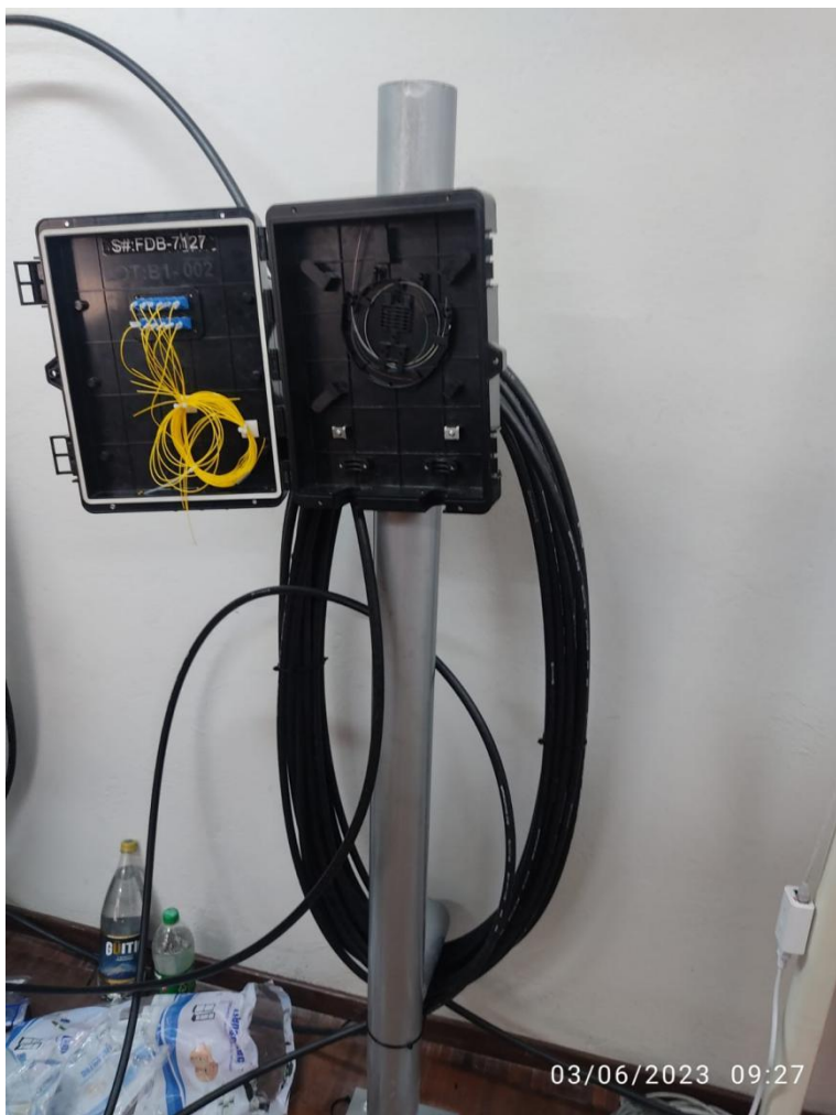
Anexo 23. Sangrado y preparación de fibra para la fusión
