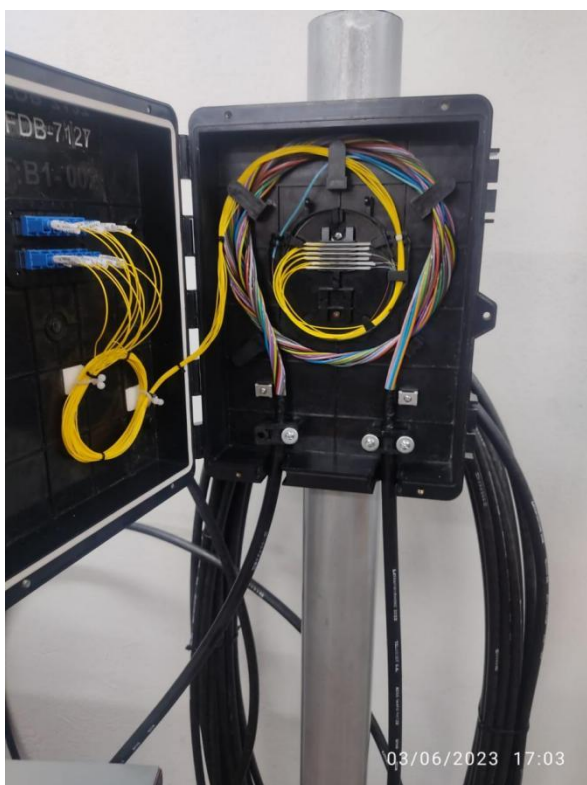
Anexo 28. Terminal (caja de dispersión) fusionado y listo para su uso
