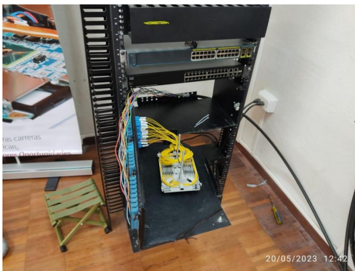
Anexo 15. Colocación del OFD de fibra en el rack de datos del Instituto
