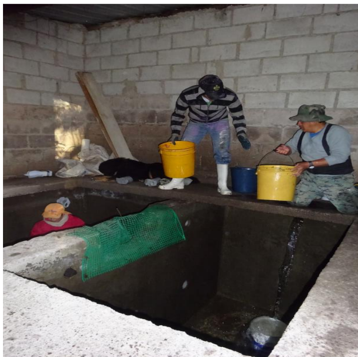
Figura 29: Minga realizada para limpieza de tanques y potabilización del agua. Fuente: Autor. 08 de abril del 2019.
