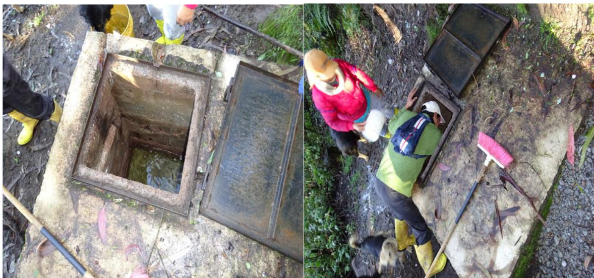
Figura 41: a. Cámara rompe presión.
