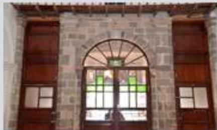
⑧ **Mampara:** se aprecia un arco de medio punto, el material de construcción empleado es piedra andesita.
