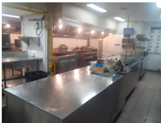
Figura 10: Cocina del restaurante “La Hacienda”
