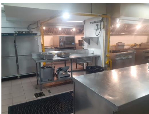
Figura 11: Cocina del restaurante “La Hacienda”
