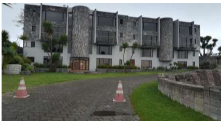
Anexo 89 Infraestructura del hotel. El cráter 2022
