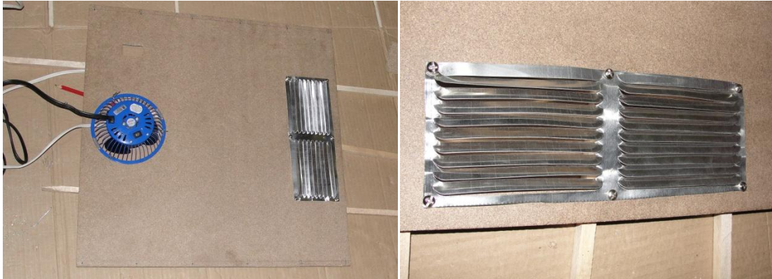
Gráficos no.23-24. Instalación del ventilador y escotilla para evacuación de aire.
