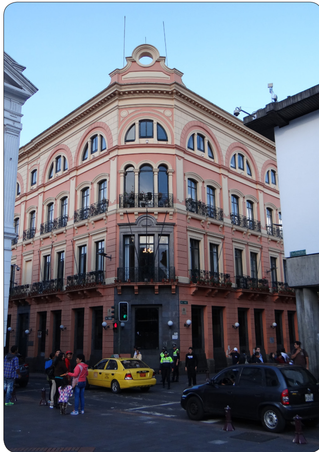
Edificio Pallares en la actualidad, donde se encontraba el Hotel Metropolitano, este fue entregado a la empresa Quito Turismo. Fuente: David Albán.
