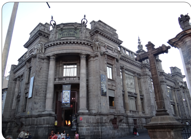
Ex sede del Banco de Fomento, y del Banco Central del Ecuador. Fuente: David Albán.
