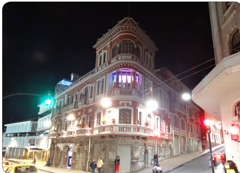
Fachada del Hotel Internacional, ubicado en el centro Histórico de Quito cerca del teatro Sucre remodelado. Fuente: David Albán.
