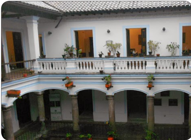
Vista interior del Inmueble. Fuente: David Albán.
