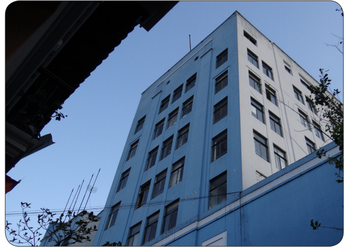
El primer edificio de gran altura del Centro Histórico de Quito. Fuente: David Albán.
