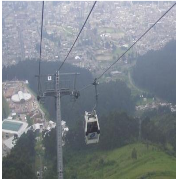
Foto: El Teleférico de Quito Anexo: No 34
