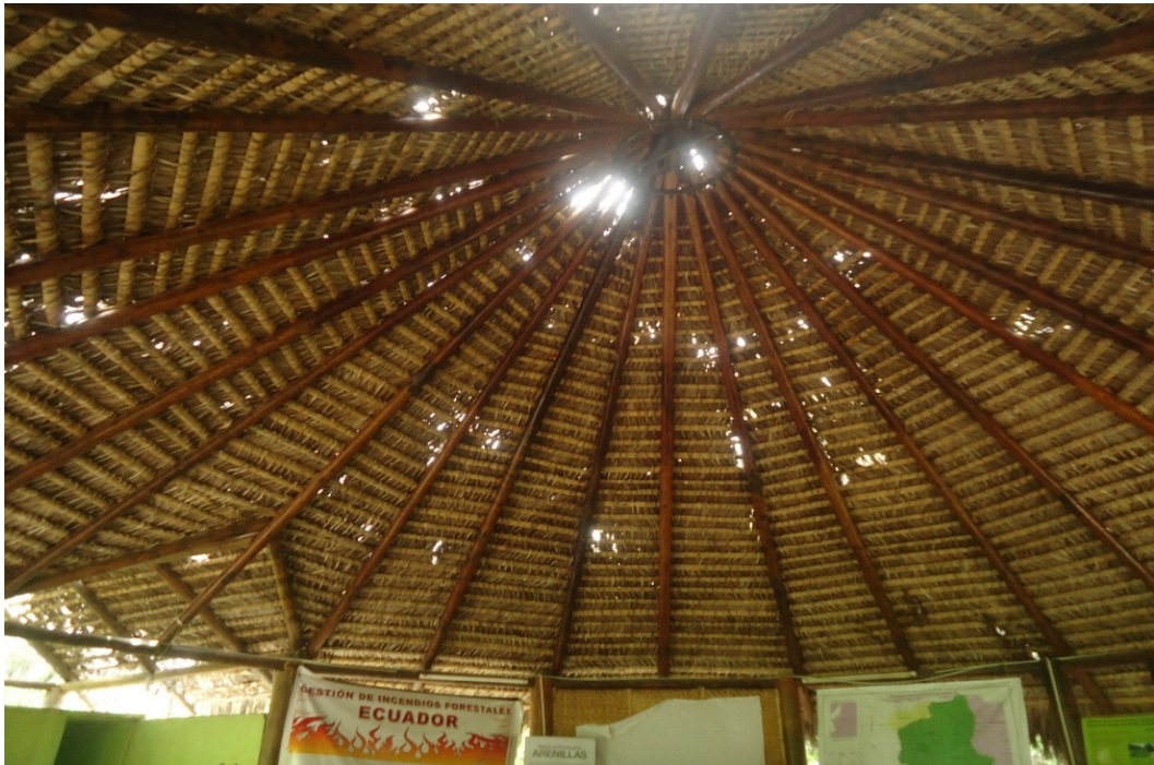
Figura N° 20 Techo Cabaña Reserva Ecológica Arenillas Fuente Reserva Ecológica Arenillas
