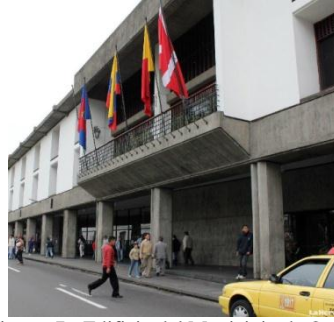
Figura 7.- Edificio del Municipio de Quito Tomado de (hoy, 2009)
