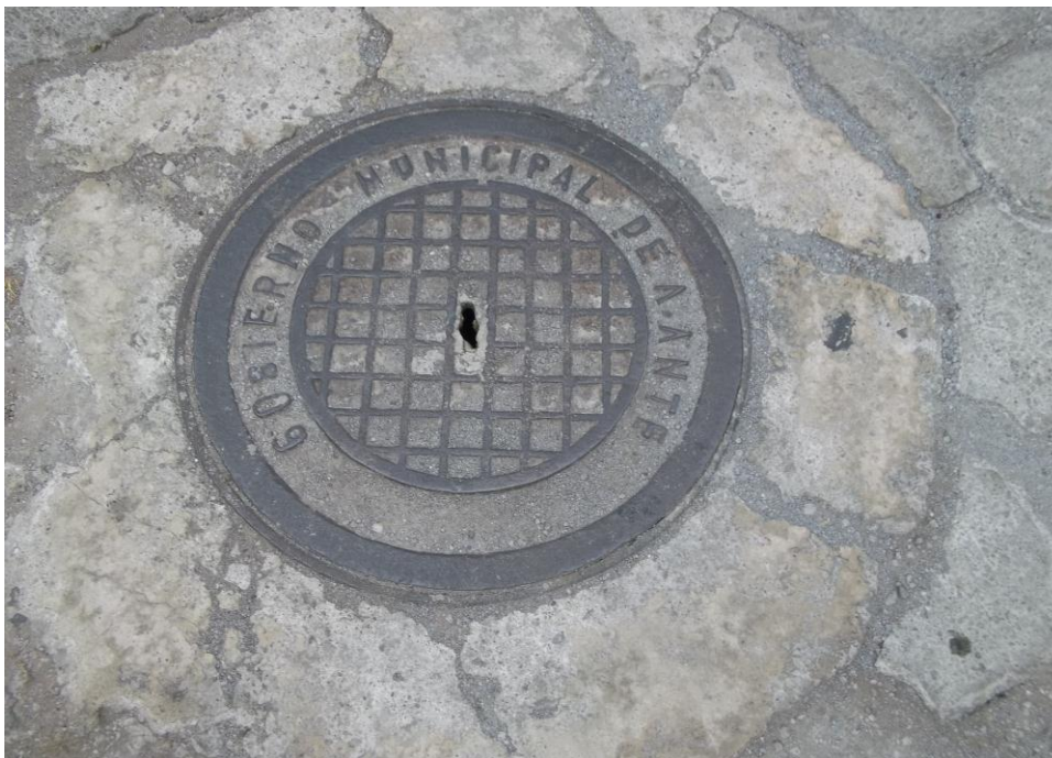
Fotografía N°12: Alcantarillado en muy excelentes condiciones. © Autor Pablo Sebastián Chiriboga Villacreces
