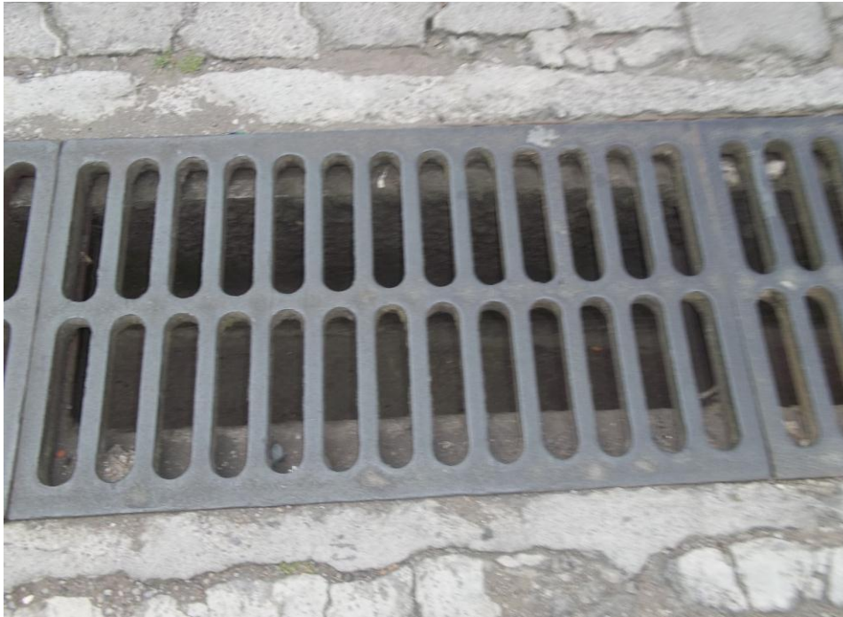
Fotografía N°11: Alcantarillado en muy excelentes condiciones. © Autor Pablo Sebastián Chiriboga Villacreces
