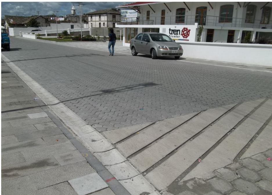
Fotografía N°6: Aceras y calles en muy excelentes condiciones. © Autor Pablo Sebastián Chiriboga Villacreces
