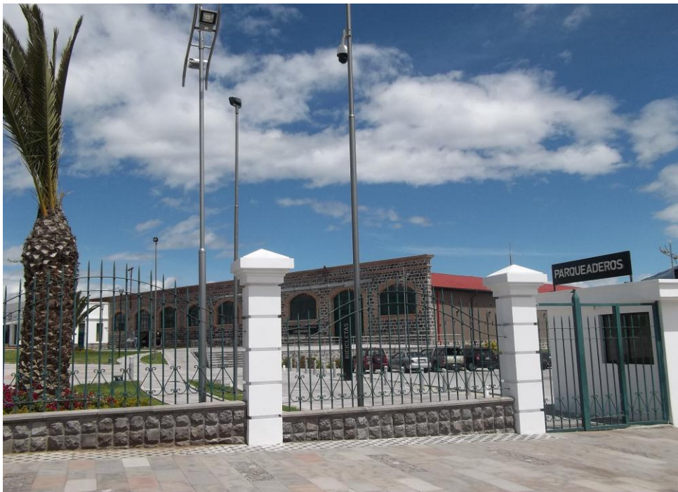
Fotografía N°10: Guardianía y verjas de seguridad del ingreso de la Fábrica Imbabura. © Autor Pablo Sebastián Chiriboga Villacreces
