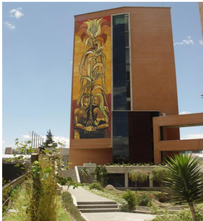
Gráfico No.1. Imagen del Edificio Manuela Sáenz donde funciona
